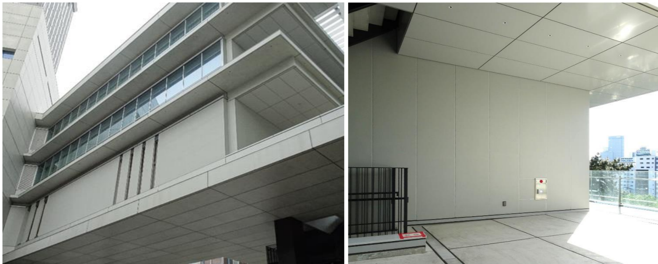
法政大学市ヶ谷キャンパス 押出成形セメント板
